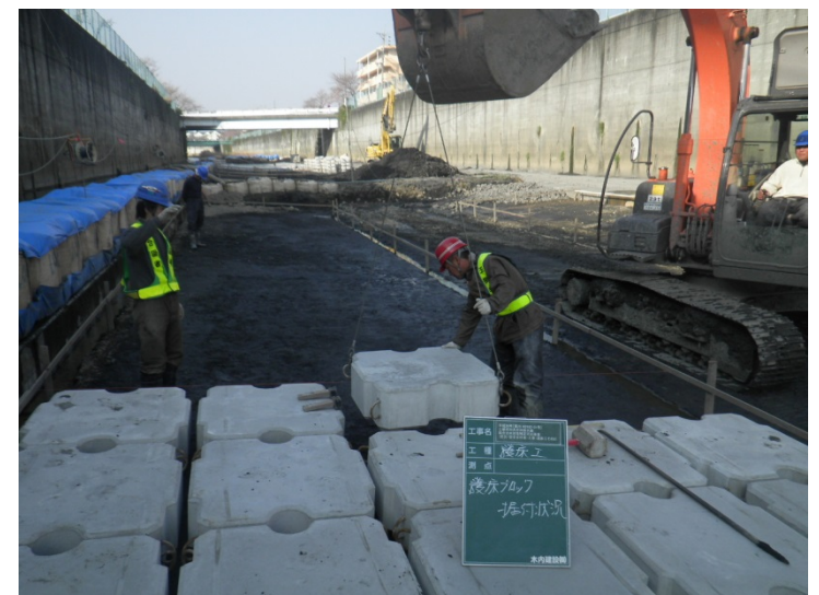
護床ブロック 据付状況
