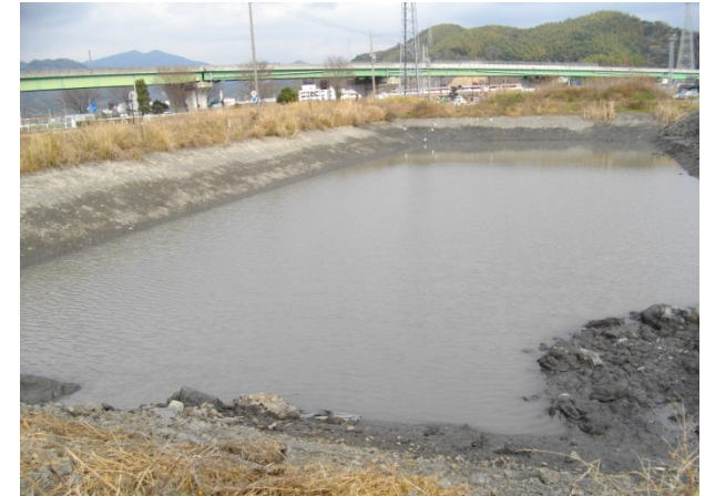
安東川エリア 掘削工
