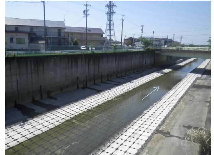
護床ブロック 据付状況
