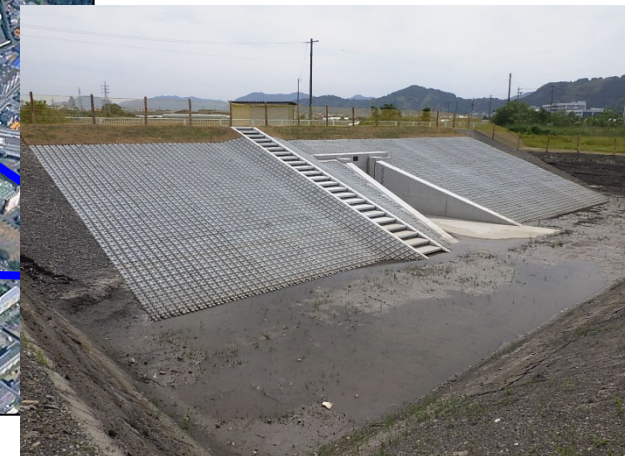
安東川エリア 排水樋門工
