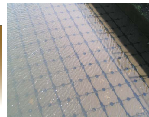
コンクリートブロックによる護床工
