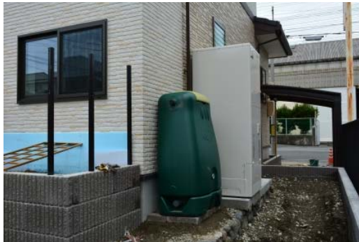
参考) 雨水貯留タンクの設置状況
